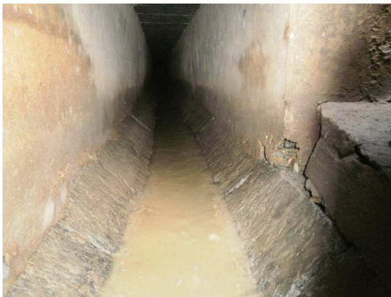
Fig. 2 – Interno del vecchio canale in cemento 500 mm x 700 mm
