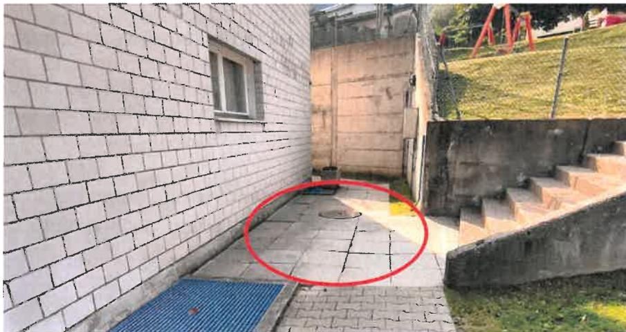
Figura 5: pavimentazione in lastre di cemento leggermente irregolare
