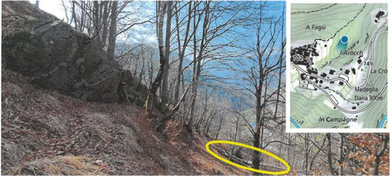
Foto 7 Situazione tipo lungo la fascia rocciosa, con presenza di parete rocciose o accumulo di blocchi sopra cui si trovano alberi o con presenza di alberi nella parte basale: in entrambi i casi un rovesciamento, anche parziale, di uno o più degli esemplari potrebbe generare un innesco di rotolamento di porzioni lapidee o blocchi interi. Nell'immagine si vede anche una ceppaia di alberi divelta con tronchi attaccati e (quasi completamente) a terra (in giallo).
